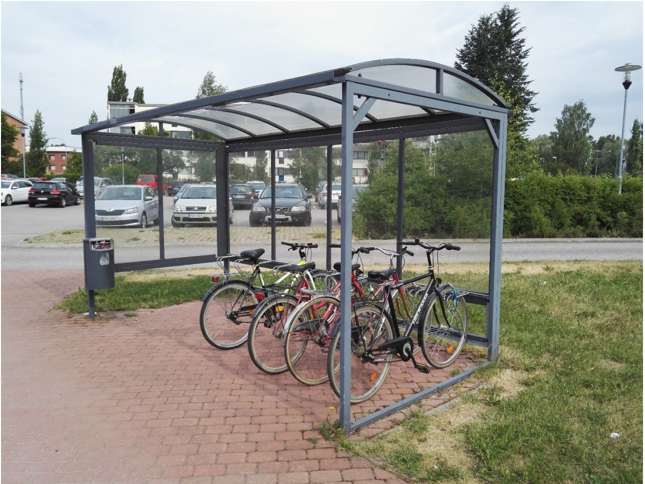
Kuva 38 Pyörätelineen katos Mäntsälän terveysaseman sisäänkäynnillä
