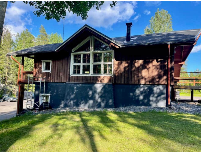
Helikopterikenttä ja sen vieressä oleva huolto- ja kokouskäytössä oleva rakennus
