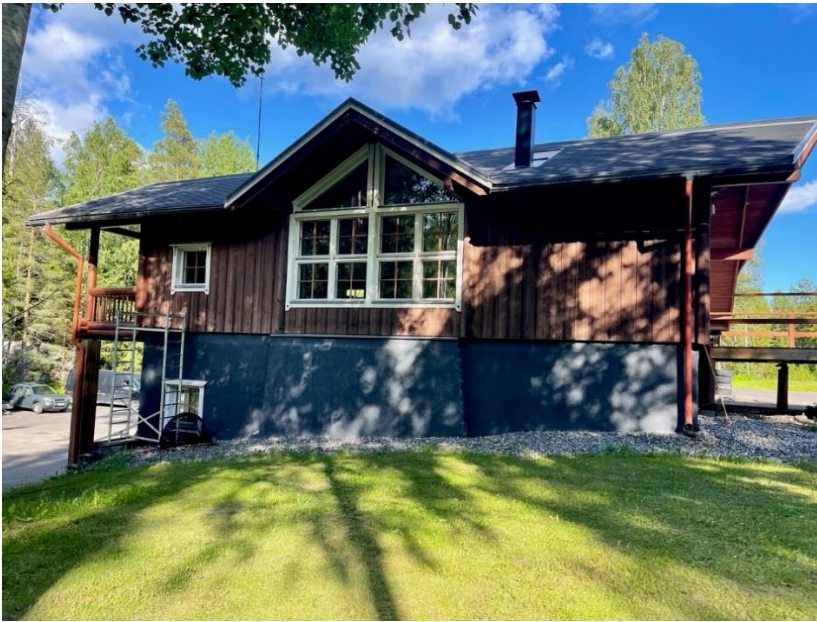
Helikopterikenttä ja sen vieressä oleva huolto- ja kokouskäytössä oleva rakennus
