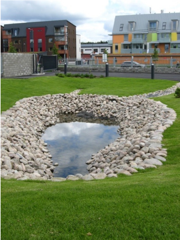
KUVA 4. A) HULEVESIEN VIIVYTYSALLAS PIHA-ALUEELLA, LASTAUS- JA PAIKOITUSALUE. B) HULEVESIENVIIVYTYPAINANNE PIHA-ALUEELLA, KERROSTALO. (KUVA: LEENA SÄNKIAHO, PÖYRY FINLAND OY)
