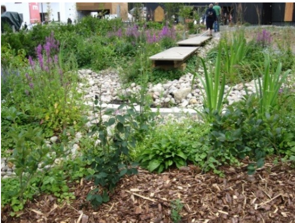
KUVA 5. A) SADEPUUTARHA, OMAKOTITALO. B) ALUEELLINEN HULEVESIEN VIIVYTYSALLAS. (KUVA: LEENA SÄNKIAHO, PÖYRY FINLAND OY)
