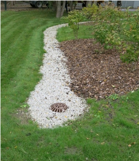
KUVA 6. A) HULEVESIEN JOHTAMISEEN TARKOITETTU PAINANNE. B) MATALA KATUKIVEYS, JONKA YLI HULEVEDET PÄÄSEVÄT JOHTUMANA NURMIKOLLE. (KUVA: LEENA SÄNKIAHO, PÖYRY FINLAND OY)
