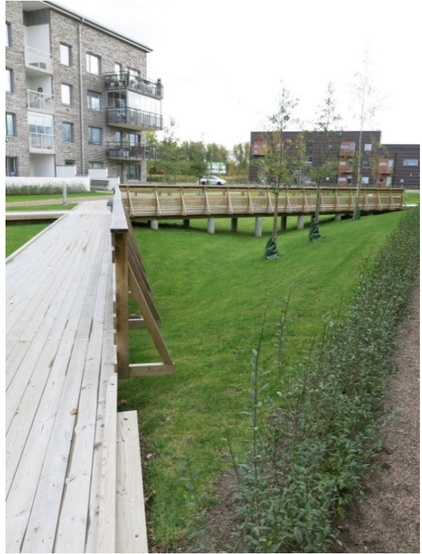
KUVA 4. A) HULEVESIEN VIIVYTYSALLAS PIHA-ALUEELLA, LASTAUS- JA PAIKOITUSALUE. B) HULEVESIENVIIVYTYPAINANNE PIHA-ALUEELLA, KERROSTALO. (KUVA: LEENA SÄNKIAHO, PÖYRY FINLAND OY)
