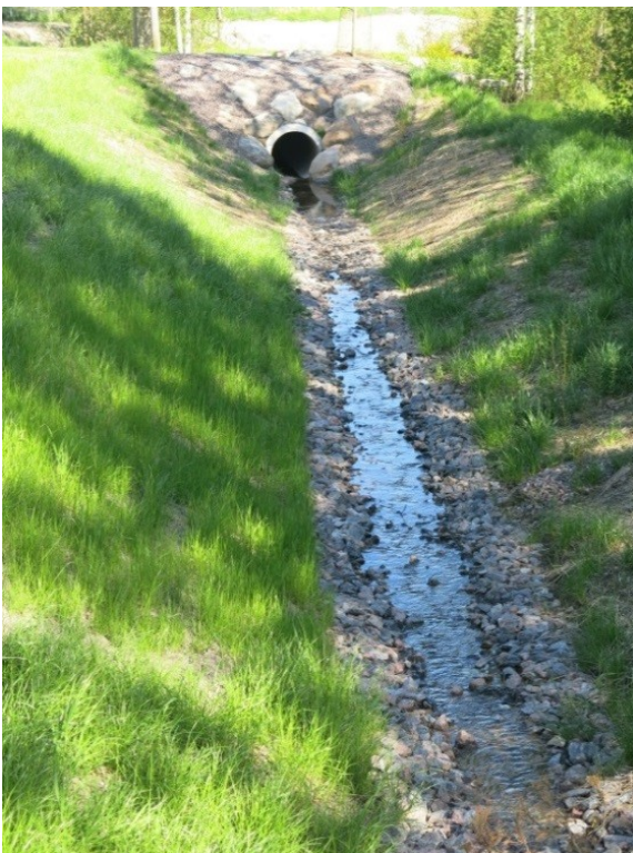
KUVA 7. KUNNOSTETTUA JA EROOSIOSUOJATTUA AVOUOMAA (KUVA: LEENA SÄNKIAHO, PÖYRY FINLAND OY)
