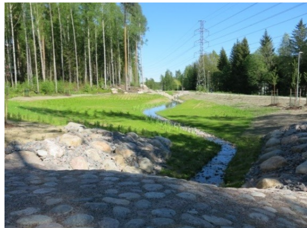
KUVA 5. A) SADEPUUTARHA, OMAKOTITALO. B) ALUEELLINEN HULEVESIEN VIIVYTYSALLAS. (KUVA: LEENA SÄNKIAHO, PÖYRY FINLAND OY)
