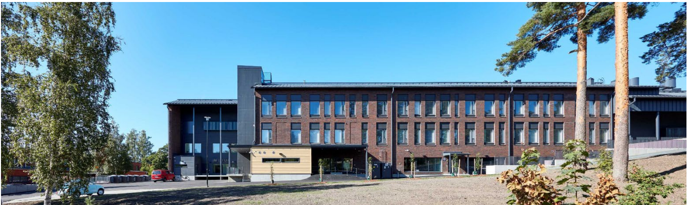
Ehnroosin koulun puhtaaksimuurattu tiilinen julkisivu Vanhan Porvoontien suuntaan, Ajan Arkkitehdit Oy
