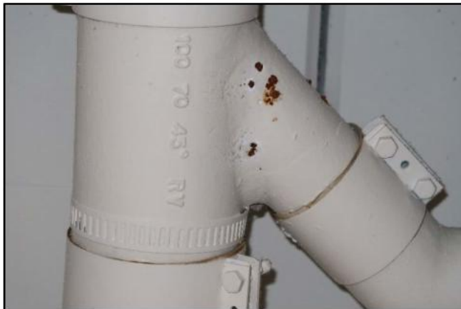
Ison liikuntahallin varasto. Pystyviemäreiden haara- ja mutkakappaleissa havaittiin läpituokevaa pistesyöpymää.
