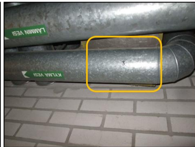
RTG- kuva 3: Kylmäveden sinkityn teräsputken suoralta osuudella havaitaan hyvin voimakasta saostumaa ja syöpymää. Kuntoluokka 3, välttävä.
