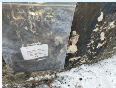
Kuva 15. 001, bitumisivelyt lattian betonilaatan päällä ei sisällä asbestia (HA11)
