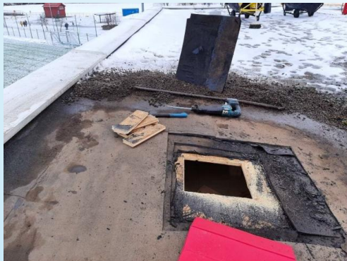
Kuva 126. YP1, lehtilukusalin yläpuolella. Bitumikermejä on avauksen kohdalla kolme kerrosta.
