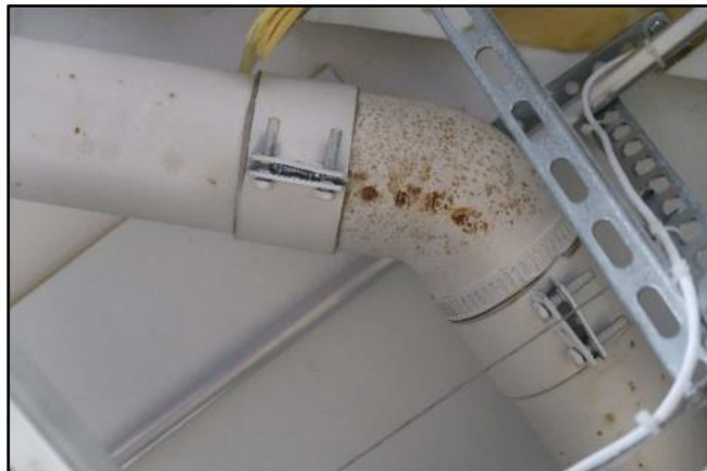
Ison liikuntahallin varasto. Pystyviemäreiden haara- ja mutkakappaleissa havaittiin läpituokevaa pistesyöpymää.
