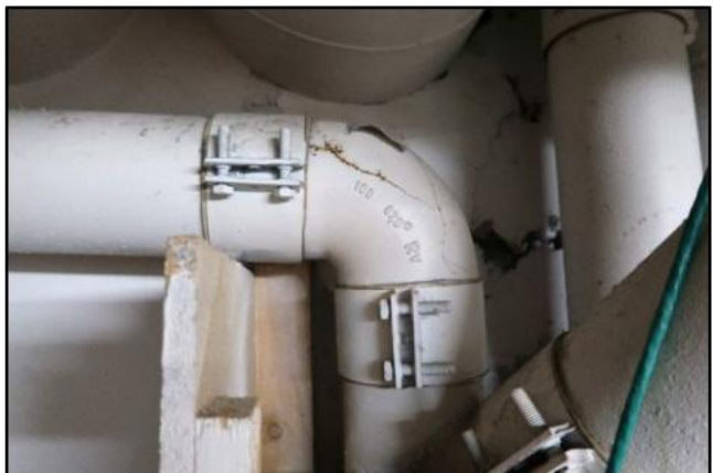
Ison liikuntahallin varasto. Pystyviemärin haarakappaleessa ilmeni vakava halkeama ja reikä. Oikealla kuvasuurennos vikakohdasta.
