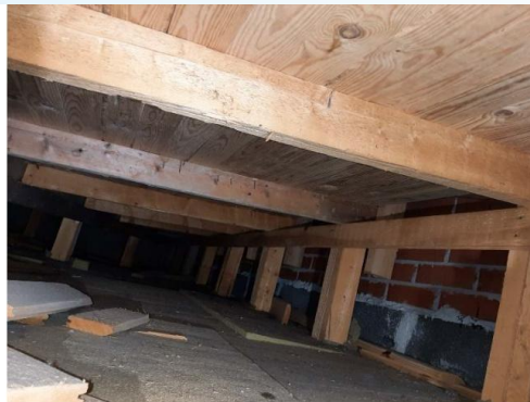
Kuva 127. Ulkoseinä on oikealla. Puurakenteet erinomaisessa kunnossa, eikä runkorakenteissa ole merkkejä vaurioista.
